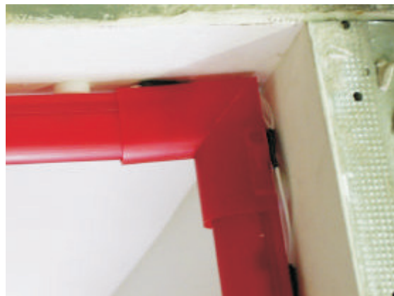
Innenecke mit aufgestecktem Eckstück
